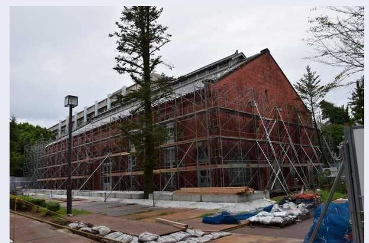
仮設補強用の土台設置 (2017/9)
