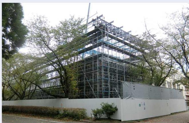
化学実験場の素屋根鉄骨工事・外部足場工事 (2018/9)
