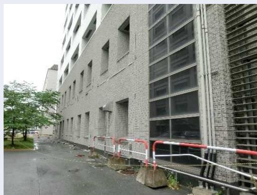
建物外壁タイルの崩落
