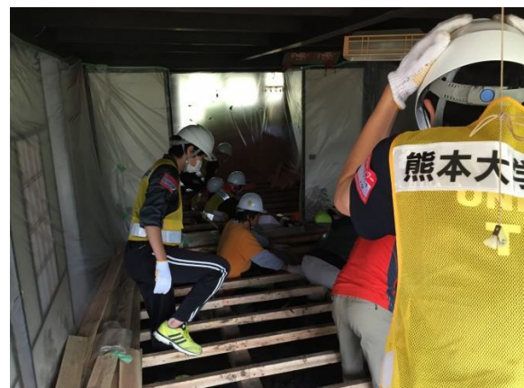
震災後の豪雨によって床下に入り込んだ土砂を掘り出す作業
