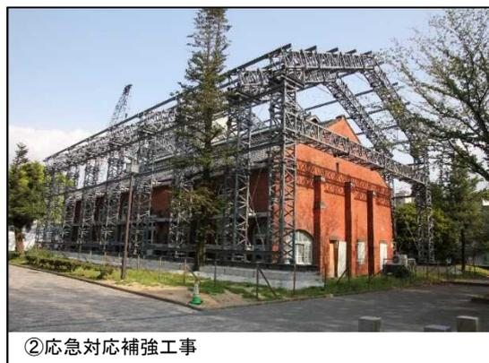
②応急対応補強工事
