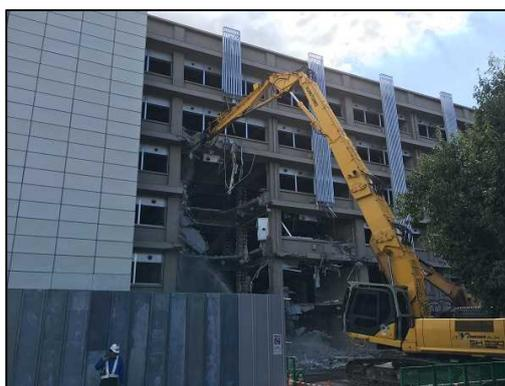
②重機での外壁取り壊し工事開始
