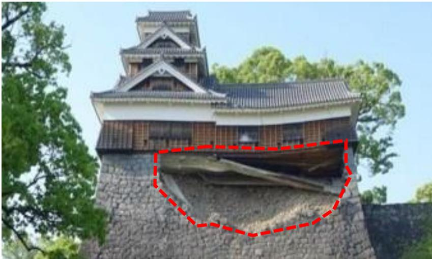
図1. 崩落した飯田丸五階櫓の石垣
