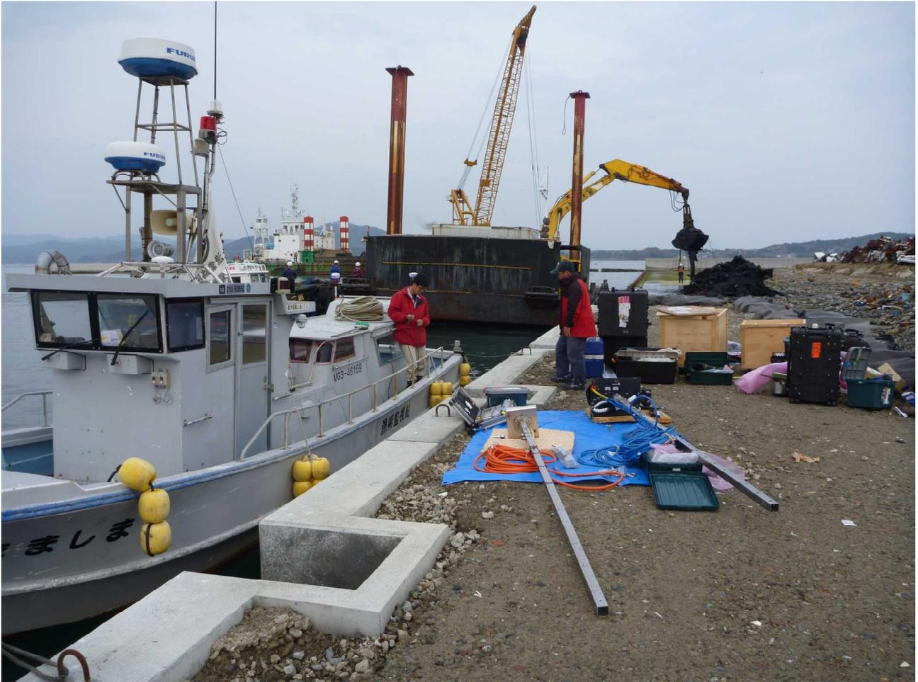
海中の瓦礫処理現場での音響解析装置の艀装作業（2011. 11. 28：波路上漁港にて）
