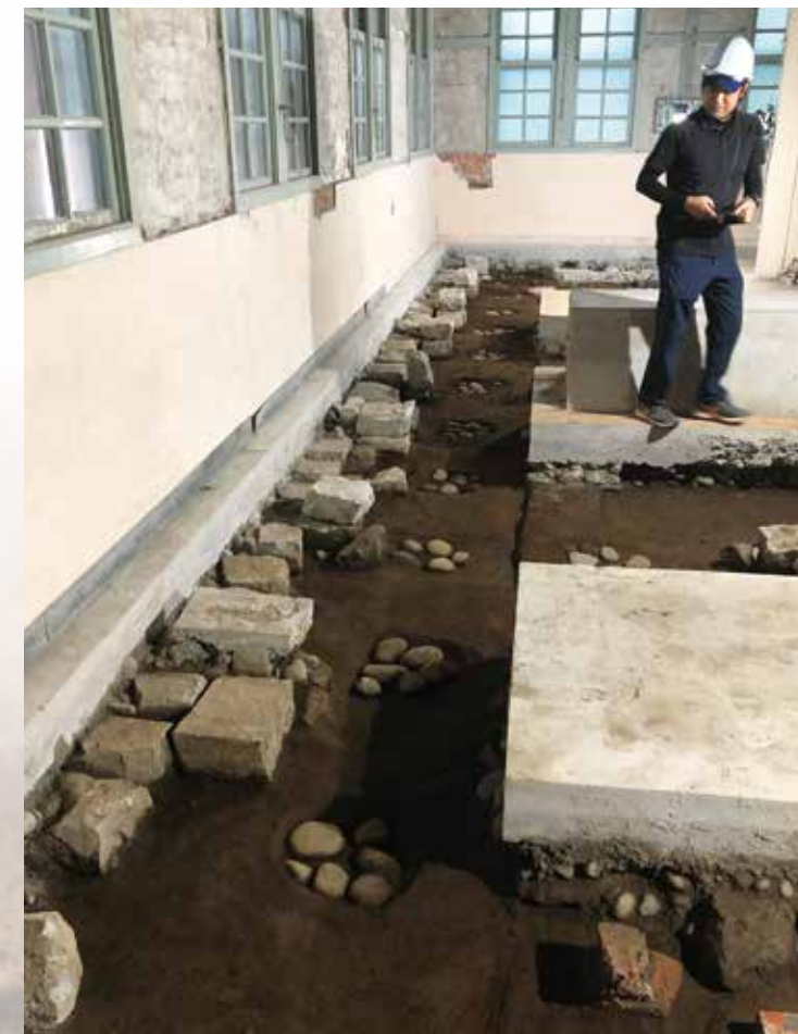
工学部研究資料館地下の束石基礎
