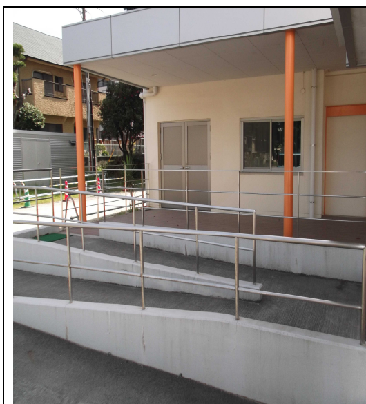
体育館のスロープ 多目的ホールのスロープ
