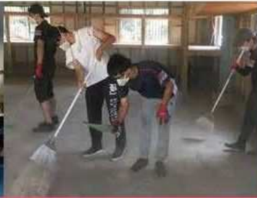
壊れた建物から瓦の破片を出し
