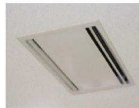
全熱交換器(ぜんねつこうかんき)は、部屋の換気に使用される機器で、換気によって失われる熱エネルギーを交換回収する省エネルギー換気装置です。
