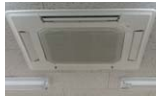
空調機取替後▶
