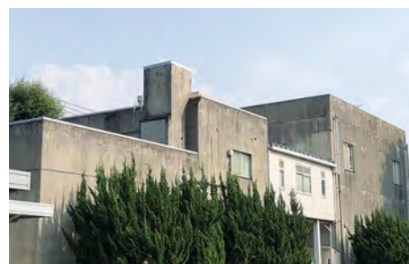
環境安全センター外観
