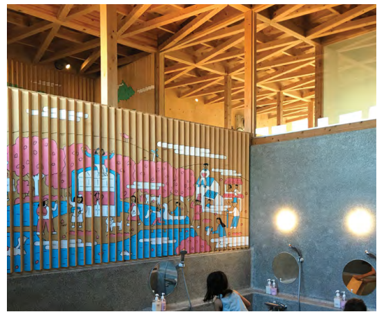
黒岩准教授が自宅1階で運営している「神水公衆浴場」の屋根は、木でかみ合わせる「嵌合接合」という手法を採用
