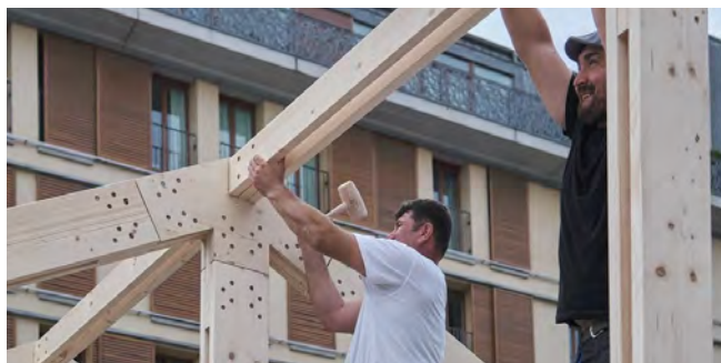
ドイツのフランクフルトで設計した簡易ハウス。接合部に木の「込み栓」を使用
