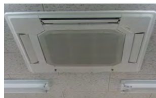
空調機取替後▶
