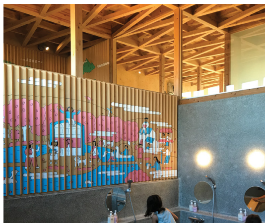
黒岩准教授が自宅1階で運営している「神水公衆浴場」の屋根は、木でかみ合わせる「嵌合接合」という手法を採用
