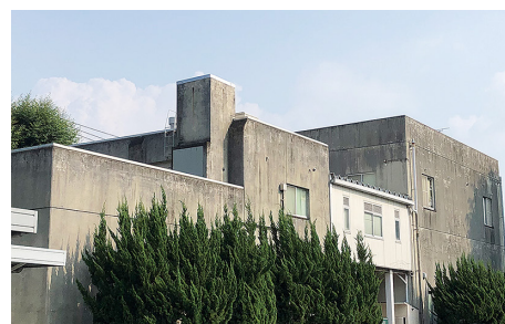
環境安全センター外観
