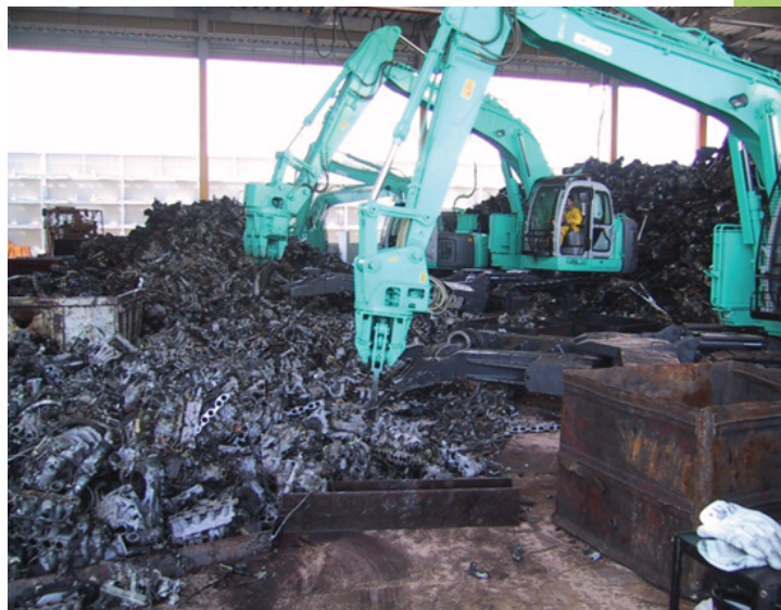
21世紀の自動車リサイクル技術革新のもう1つの要は自動車解体機(緑色の自動車解体用の重機)の開発である。この機械は現在日本人が経営する解体工場のほとんどで導入されている。非常に正確に銅や鉄を分解して取り外すことのできる機械である(2003年、富山エコタウンの自動車解体業者にて、外川撮影)。
