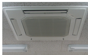
空調機取替後▶
