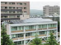
共用棟黒髪2 26kW
