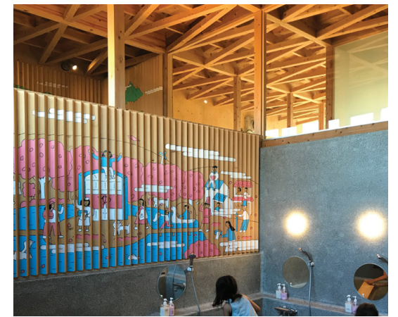
黒岩准教授が自宅1階で運営している「神水公衆浴場」の屋根は、木でかみ合わせる「嵌合接合」という手法を採用
