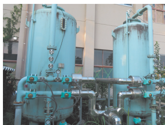
受水槽(井水を貯めています)
