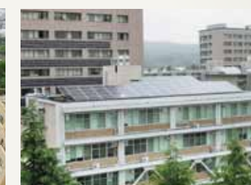
共用棟黒髪2 26kW
