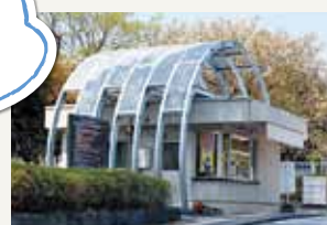
ソーラードーム
