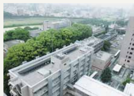
研究実験棟屋上 50kW
