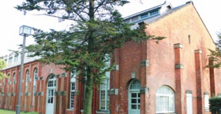
工学部研究資料館 《国指定重要文化財》 熊本高等工業学校の機械 実験工場として1908 (明治41)年に竣工した
