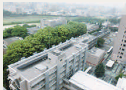
研究実験棟屋上 50kW
