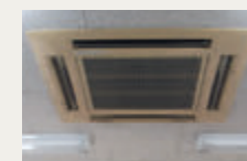
空調機取替前
