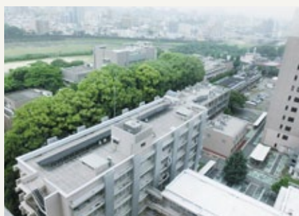
研究実験棟屋上 50kW
