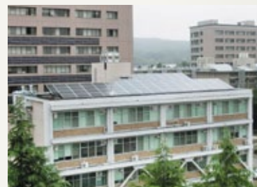
共用棟黒髪2 26kW
