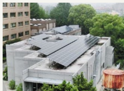
学生食堂 (FORICO) 屋上 30kW
