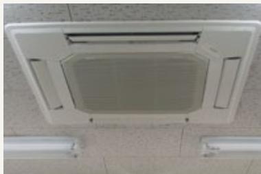
空調機取替後
